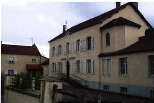
Une maison de retraite en bordure de la RD967 à PERCEY
