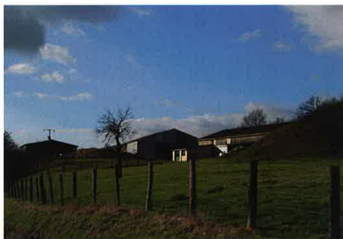
Bâtiments d'exploitation le long de la 241 s'intégrant mal dans le paysage à PERCEY
