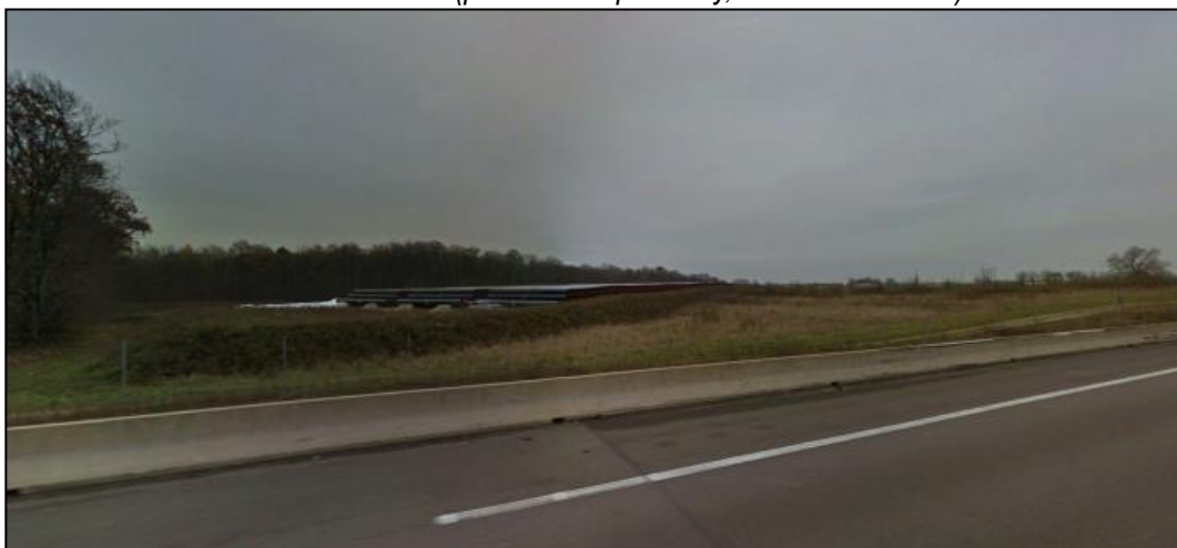
Vue n°2 du site (photo : Jacques Tilly, architecte DPLG)
