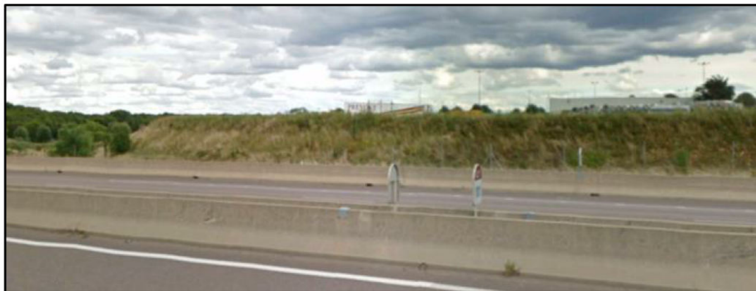
Ci-dessus une photo du site en 2017, remblayé
