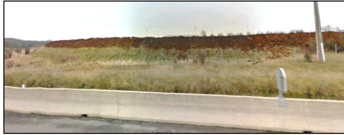
Ci-dessus une photo du site en 2016, en cours de remblaiement
