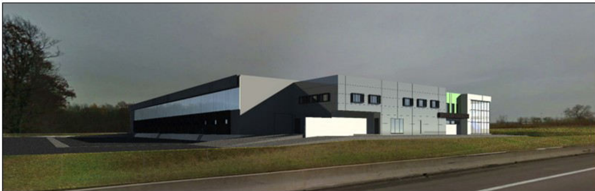
Vue projetée de l'entrepôt et du bâtiment administratif depuis l'autoroute (du Nord-ouest vers le Sud-est. Conception : Jacques Tilly, architecte DPLG)
