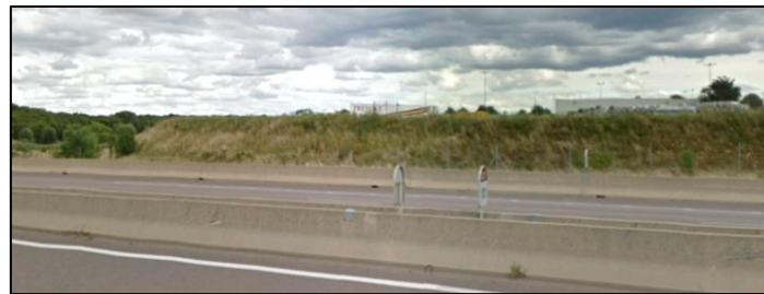
Ci-dessus une photo du site en 2017, remblayé
