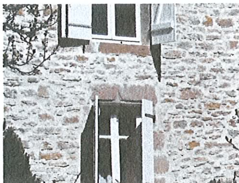
Linteau de fenêtre gothique
