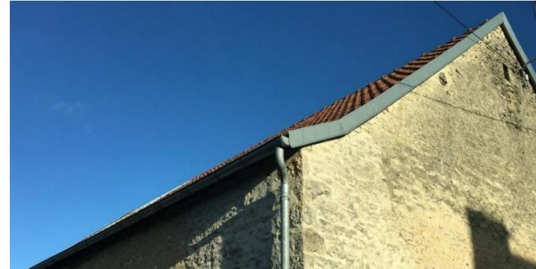
La toiture à coyaux est une toiture dont la partie inférieure d'un ou plusieurs pan(s) est relevée par une poutre. La partie basse, généralement de petite taille, est moins inclinée que la partie haute.
