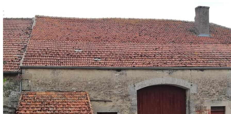
*Tuiles mécaniques à Perrogney-les-Fontaines*
