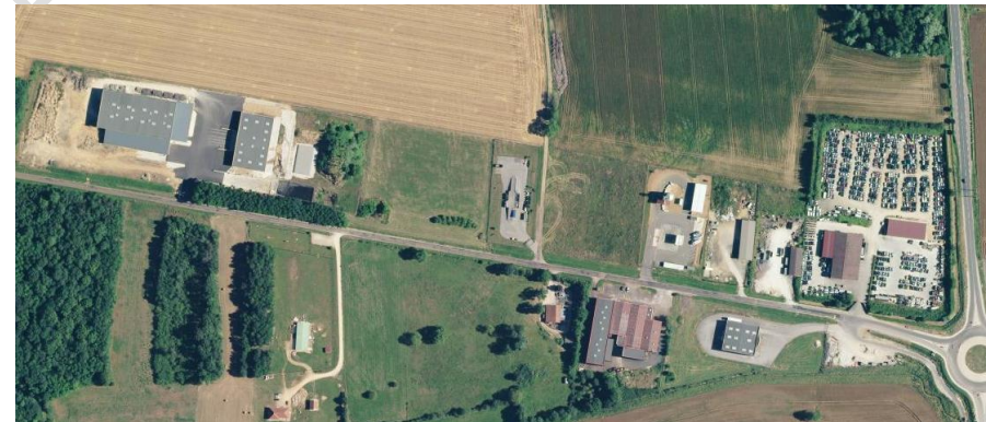
Zone industrielle & artisanale Les Epinois-Chanois – Prauthoy ; Source : Géoportail
