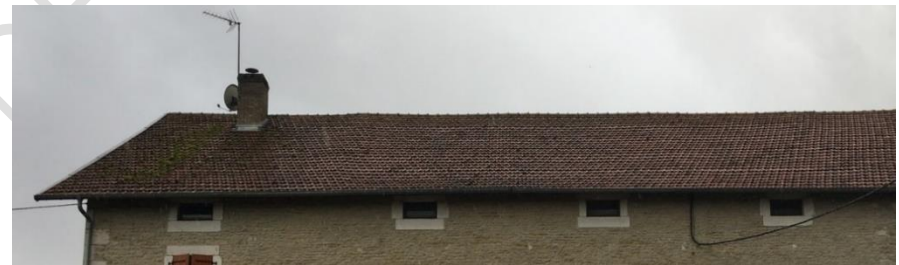
Toitures à longs pans à St-Loup-sur-Aujon
