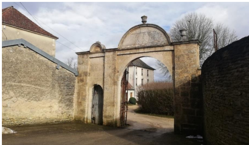
Porte cochère à Poinson-lès-Grancey, la porte cochère est en bois et le portail en fer forgé
