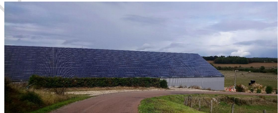
Panneaux solaires mis en place sur un bâtiment agricole à Chameroy (commune de Rochetaillée) – Source : Biotope, 2019
