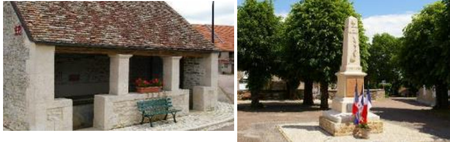
Lavoir d'Aujeures et monument aux morts de Brennes
