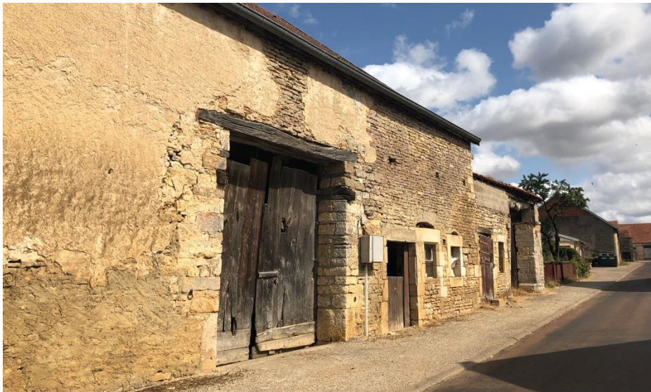
Pierre calcaire et enduit à Vaillant
