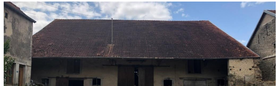
Toiture à longs pans à Grandchamp
