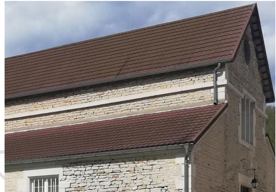
Tuiles mécaniques à Auberville
