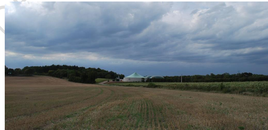
Unité de méthanisation collective de Chalancey – Source : Opale énergies naturelles
