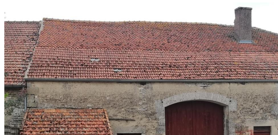
Tuiles mécaniques à Perrogney-les-Fontaines
