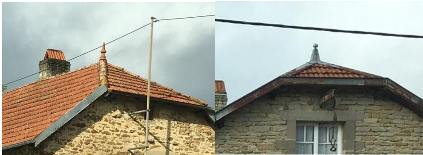
Figure 5 : Epis de faîtages en terre cuite et en zinc à Percy-le-Pautel
