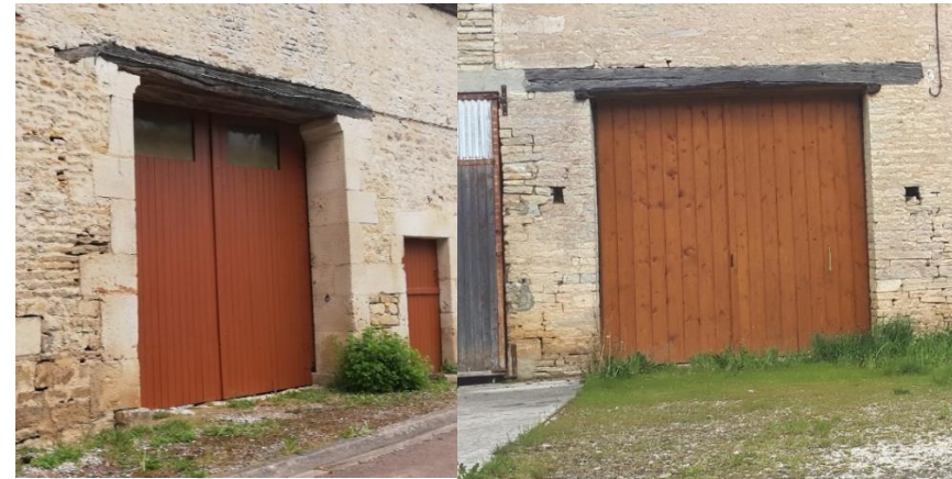
Portes de grange et d'étable avec linteaux en bois à Perrogney-les-Fontaines et Vaux-sous-Aubigny
