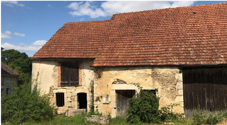
Pierre calcaire et enduit à la chaux - Cohons
