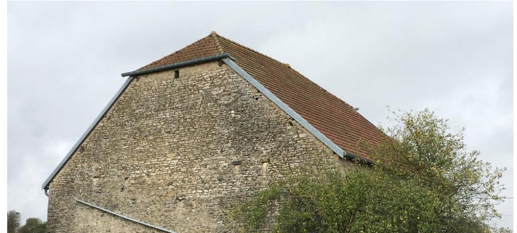
Toiture à demi-croupe à Longeau
