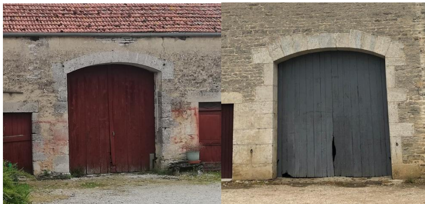
Portes de granges en bois et en arc surbaissé à Perrogney-les-Fontaines et Villegusien-le-Lac
