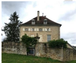
Maison de maître ou notable à Baissey
