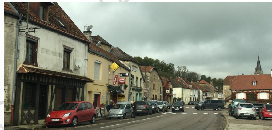
Front bâti à Longeau
