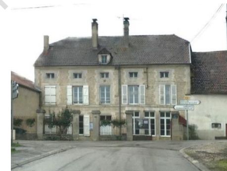
Maison de maître ou notable à Chameroy
