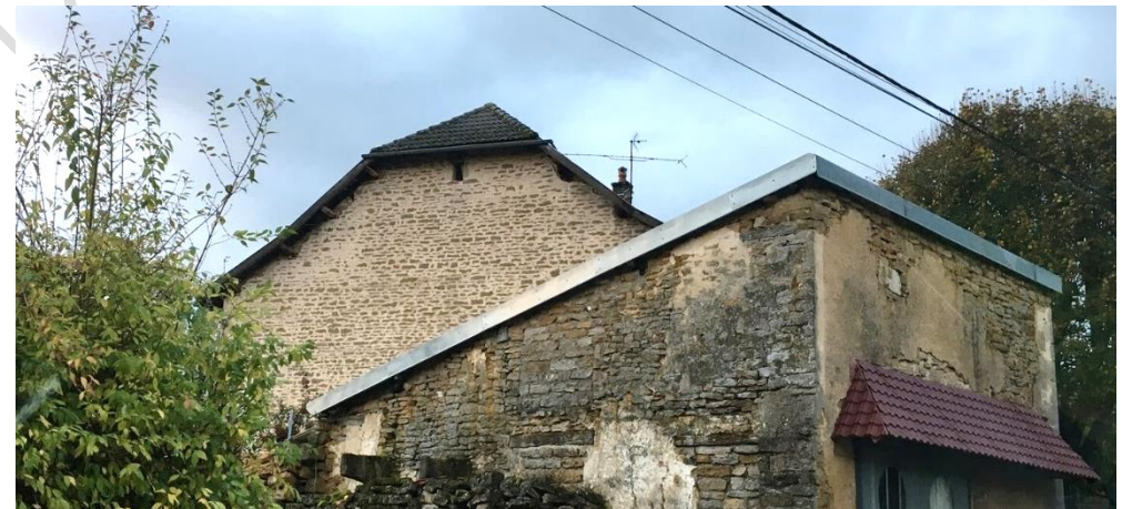
Toiture à demi-croupe à St-Broingt-les-Fosses
