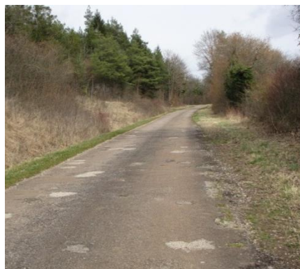
Route avant travaux d'ECF à Rouvres sur Aube
