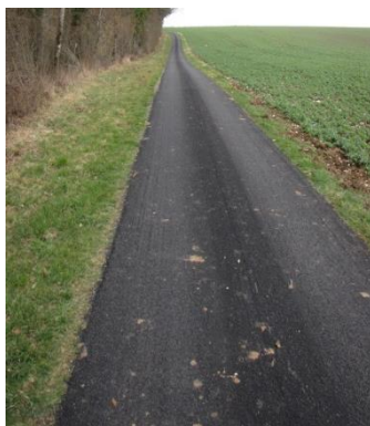
Après travaux d'ECF à Rouvres sur Aube
