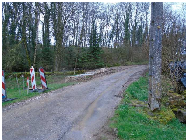
Photo du mur en gabions après travaux – (Cliché F. BIQUET)
