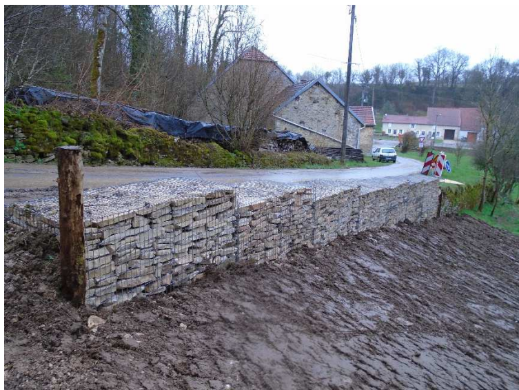
Mur après travaux (Cliché F. BIQUET).
