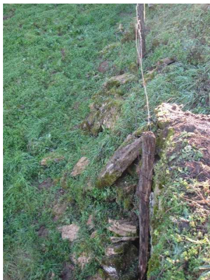
Photo du mur après travaux-Cliché F. BIQUET
