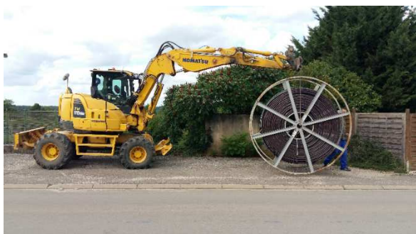
les machines nécessaires au déploiement de la fibre optique.
