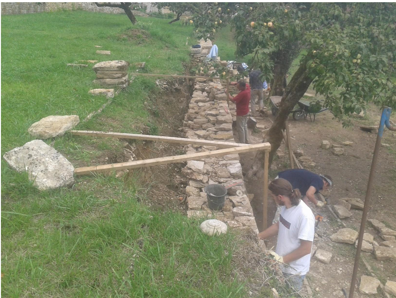
Mur de Soutènement à Cohons
