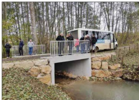
Les buses de Courcelles-Val-d'Esnois ont été remplacées par un pont.
