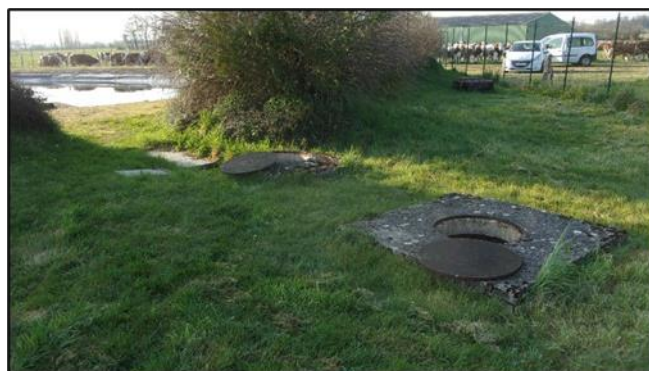
Déversoir puis regard puis dessableur
